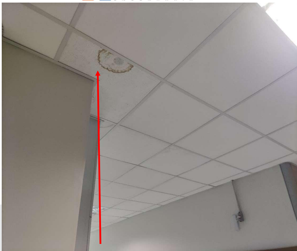
FOTO 15 – Infiltrações no forro do pavimento inferior oriundas da cobertura
