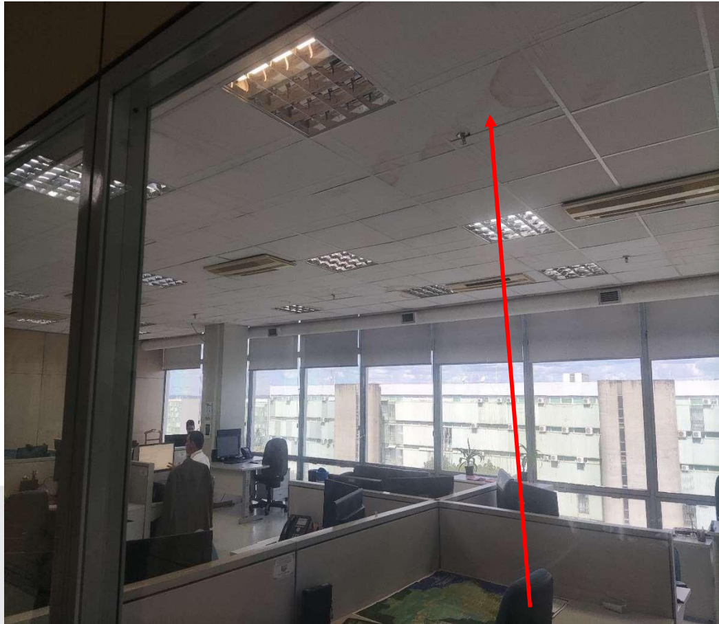
FOTO 14 – Infiltrações no forro do pavimento inferior oriundas da cobertura
