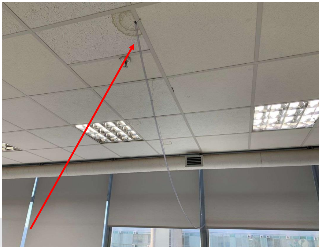
FOTO 21 – Drenos instalados para direcionar a água dos vazamentos em tambores de coleta (Solução paliativa)
