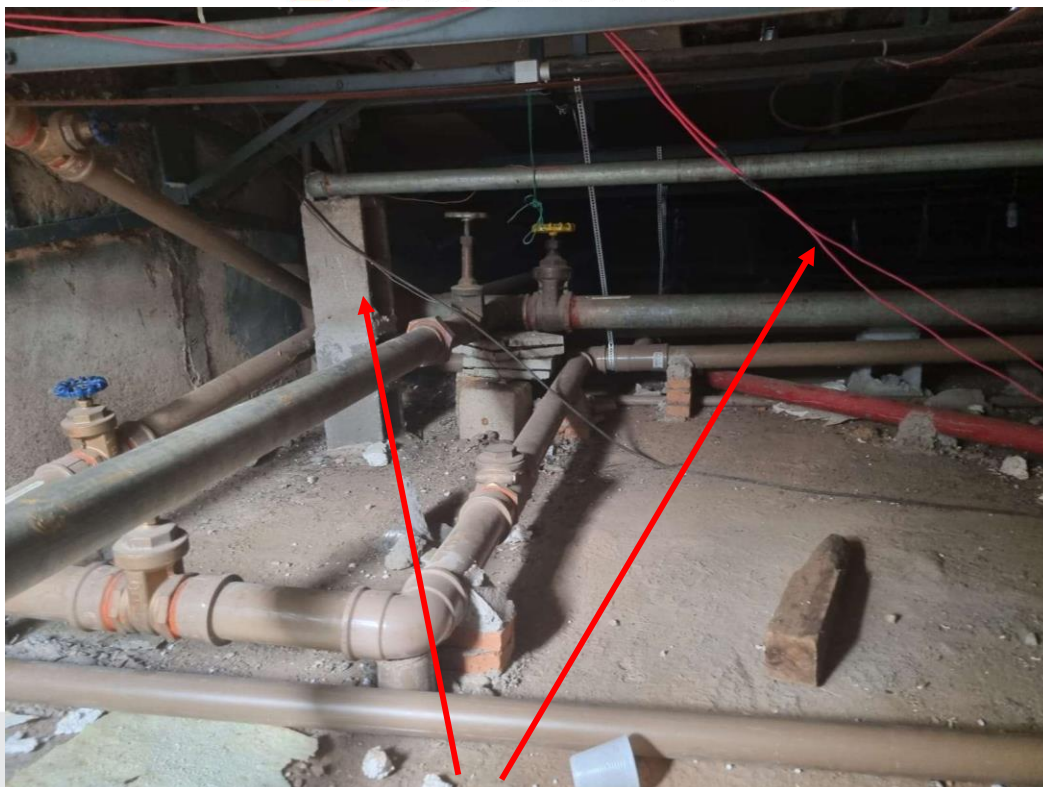
FOTO 13 – Restos de entulho e fiação exposta
