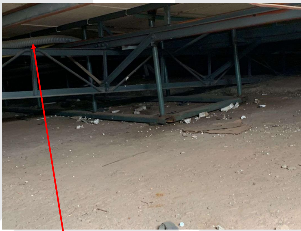
FOTO 12 – Conduítes apoiados na estrutura do telhado sem organização
