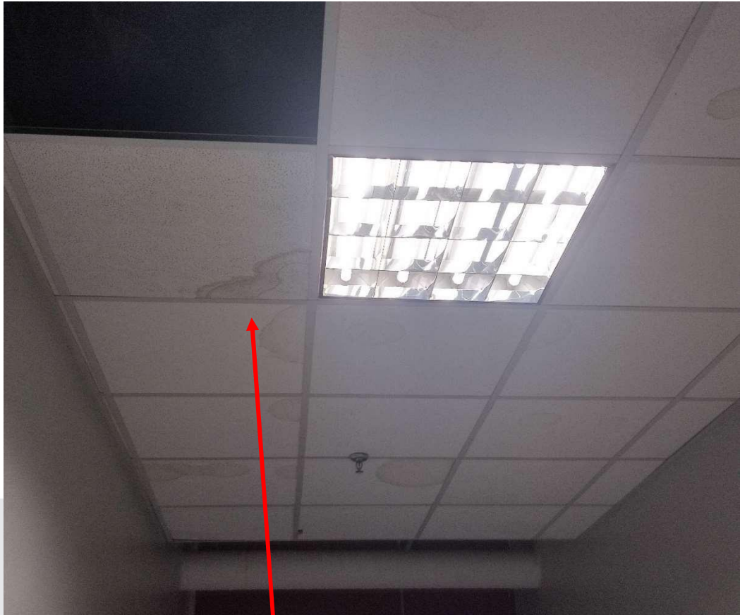
FOTO 17 – Infiltrações no forro do pavimento inferior próximo a luminárias
