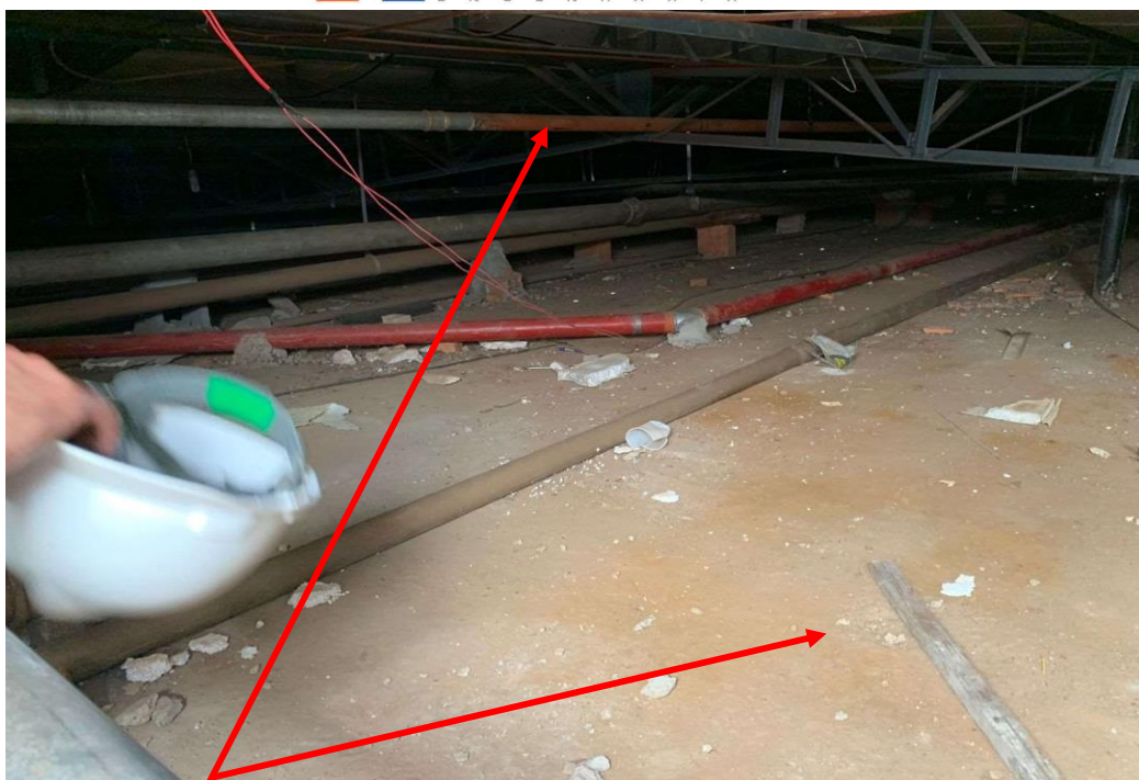
FOTO 11 – Restos de entulho e tubulações apoiadas na estrutura do telhado
